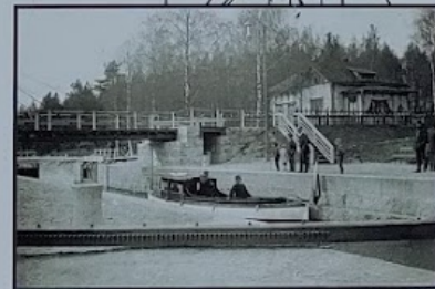
Kanavarakenne toimi kanavakäärin virka-asuntona. Ensimmäinen kanava-kaasuri (v. 1896-1898) oli Bernhard Grönroos, joka toimi kanavan rakennus- aikana myös työmaasköörinä. Alkuta työntekijöiltä kanavalla olivat sulka- varjat (suorinangit), kanavamiehet (kääntöngit) ja kanavakirjurit. Ennen sähköistystä kanavan portit ja kääntötilaa silta asettiin käsin sulka- varjojen ja kanavamiesten toimesta. (Kuvasa herraasemilla oli myös huovineidit, jolla oli nopea matkustus vesillä pötkin).
