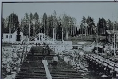
Karjalan maanitti valmistui v.1890 ja kului Karvion-kanavan yli puolta siltaa pidin. Kanavaan rakentamaan yhteydessä kaivettiin yli tult kapea (2,8 m) kääntötila, joka vaihdettiin v. 1916 leveämpään teräsiltaan. Vuonna 1960 kääntötilaa vaihdettiin vielä suurempaan ja leveämpään siltaan. Kääntötilalla peiteltä käyvästä v. 1969 uuden nykyisen sillan valmistuessa. (Kanavaa keskeisillään korjaukset vuosina 1992-1993, Oikella vasemmalla, jolla liikenne kulki).
