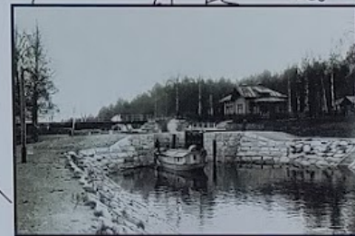
Kanavan rakentamista perusteltiin tavalliseston parempaan sujumiseen. Palo- kassa ja Kermassa oli suuret sahalaitokset, joiden tuotteita oli helpompi kuljettaa laivoilla. Rahtin kuljetus Heinäveden kirkonkylälle aiheutti suuria vaikeuksia. Karvionna lastit jouduttiin purkamaan ja tavarat siirtämään Kermajärven puolen alkuun. Kanavan valmistamisen jälkeen tavareiden kuljettaminen helpottui. Pääosan rahtikuljetuksesta kului Heinäveden ja Kuopion välillä. Täkkejä ja prappoja siitettiin myös luoja määräin kanavan läpi, puustavaran vutto suuntautui olavirtaan Heinäveden reitille. Puuta siitettiin sotien jälkeen keskimäärin 3 milj. m 3 vuodessa. (Kuvasa rahtialus menossa sulkaun).
