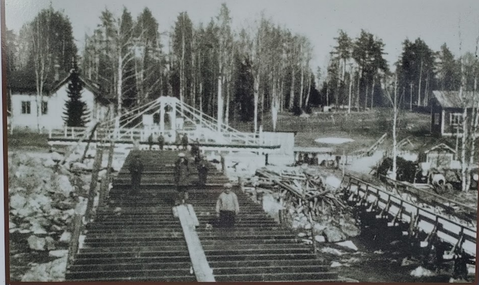
Karjalan maantie valmistui v. 1850 ja kulki Karvionkosken yli puista siltaa pitkin. Kanavan rakentamisen yhteydessä kanavan yli tuli kapea (2.8 m) kääntösilta, joka vaihdettiin v. 1914 leveämpään terässiltaan. Vuonna 1960 kääntösilta vaihdettiin vielä suurempaan ja leveämpään siltaan. Kääntösilta poistui käytöstä v. 1969 uuden nykyisen sillan valmistuessa. (Kuvassa koskensillan korjaustyö vuosina 1932–1933. Oikealla varasilta, jolla liikenne kulki).
